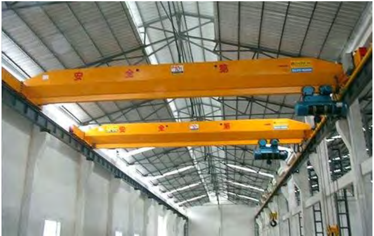
图 3.5-18 刚性填埋场上料方式
